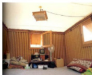
تصویر ۳- خانه با لوله‌های کاغذی در کوبه ژاپن. منبع: (URL:1)
