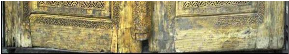
تصویر ۳- اتصالات زاویه‌دار در بر پایین لنگه‌ها (منبع: کاویانی فریز و همکاران، ۱۳۹۷: ۴)
