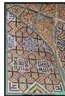
تصویر ۲۶- گره شمسه هشت و سلی طبل‌دار معقلی در بخش‌های مختلف رسمی‌بندی سقف هشتی ورودی مسجد (منبع: نگارنده، ۱۳۹۸)
