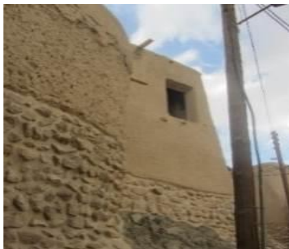
تصویر ۹- استفاده از مصالح با ظرفیت حرارتی بالا مثل سنگ و کاهگل. منبع: (نگارندگان)
